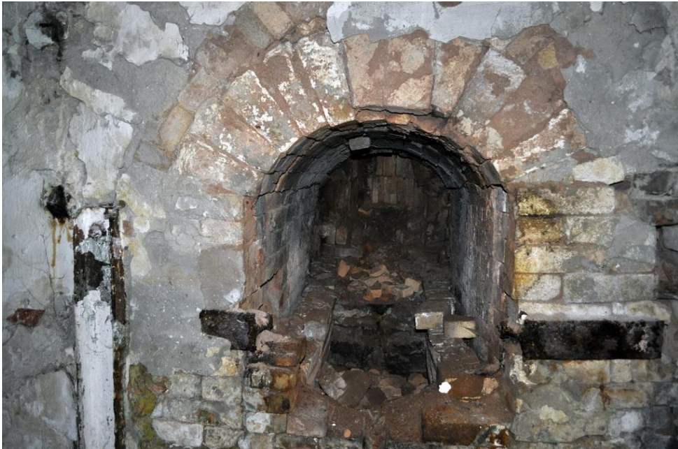
Піч для підігріву повітря сушилки.
