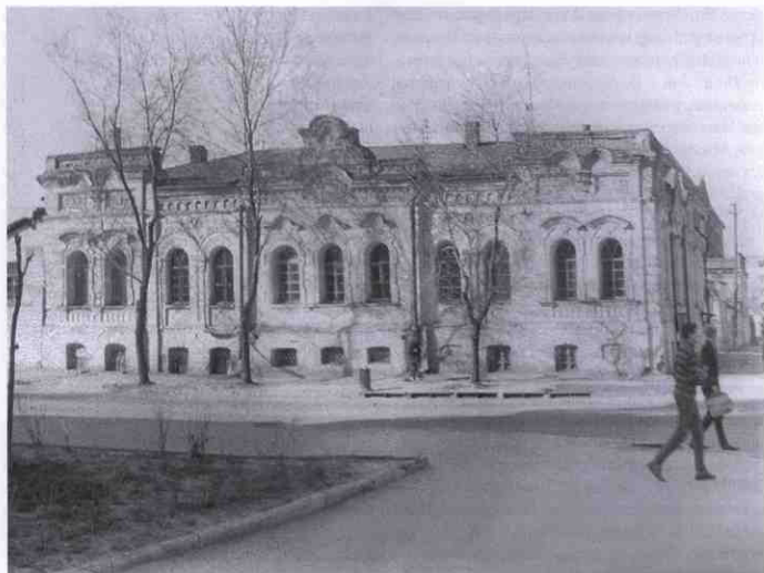
Дом В. Хренникова по ул. Клубной (ныне – Воскресенской) в Екатеринославе. Здание не сохранилось.
