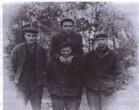
Після огляду наземного обладнання тягової підстанції
