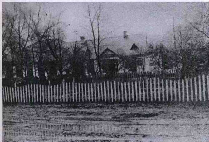
Приміщення Вульшанської школи, 1937 р.
