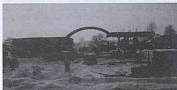
Будівництво автозаправки «OKKO».
