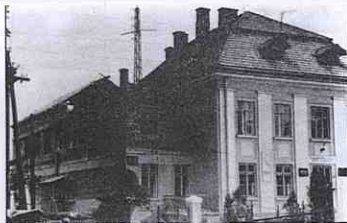
Будівництво лівого крила будинку правосуддя.
