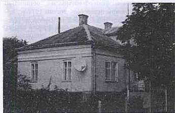
Старе приміщення молочарні.
