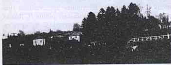
Дорога на Фільварки. 1972 р.
