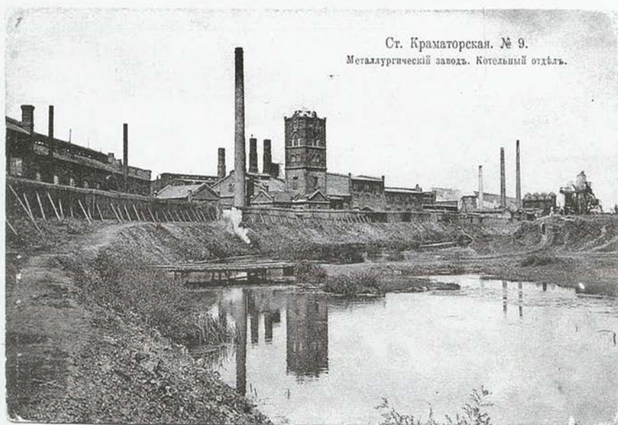
Котельне відділення заводу КМТ і ріка Казенний Торець
