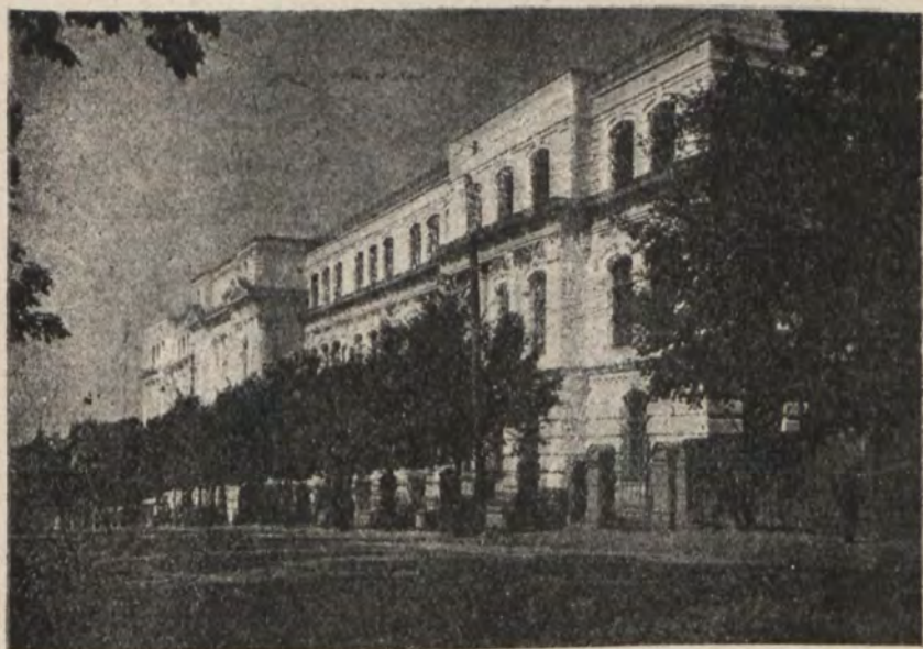
Архит. Г. П. Шляйфер. Будинок Кооперативного Інституту ім. В. Я. Чубаря. (Надбудова—1929 р.).
