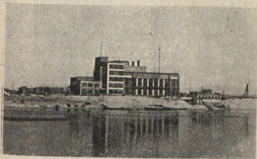
Нова Районова Електрична Станція.
